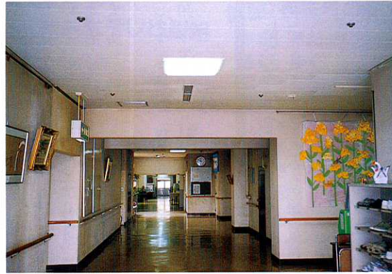
正面玄関より撮影～廊下については夜間に工事を行う
